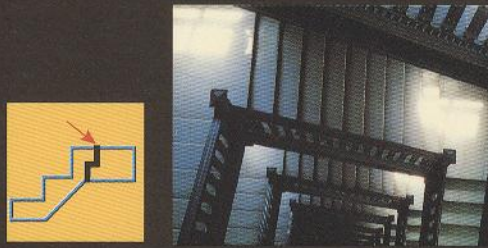
Vibration Insulation of Stairs to Floor Isolation des escaliers et étages contre les vibrations Vibrationsisolation von Treppe zu Boden
